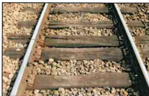
Rails courts sur traverses bois
