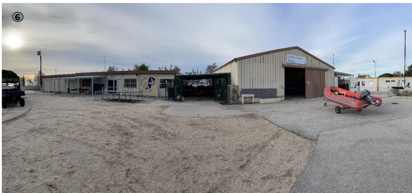
Figure 18 Photographie centre municipal de voile
