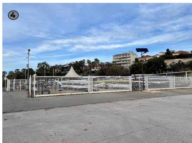
Figure 14 Photographie cales de mise à l'eau
