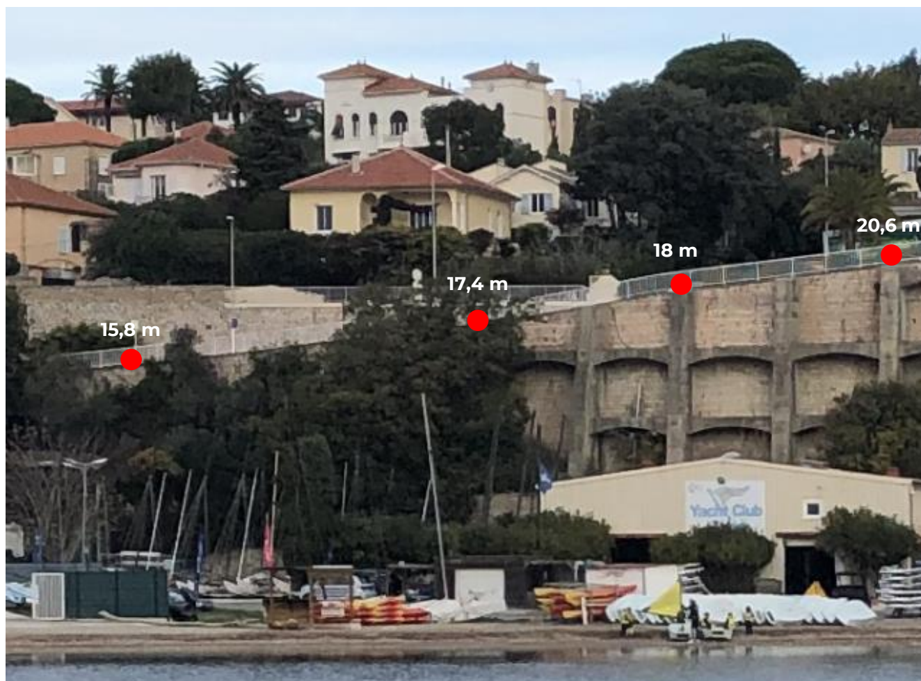
Figure 31 : Photographie hauteur du mur de soutènement
