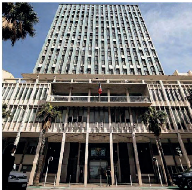
En un an, 22% d'économies d'énergie ont été réalisées
