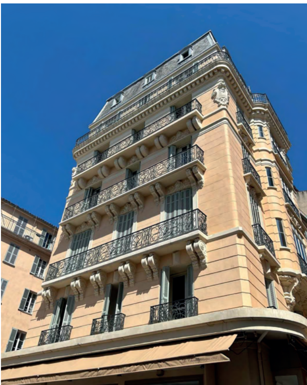
Ravalement d'un immeuble remarquable en centre ancien
