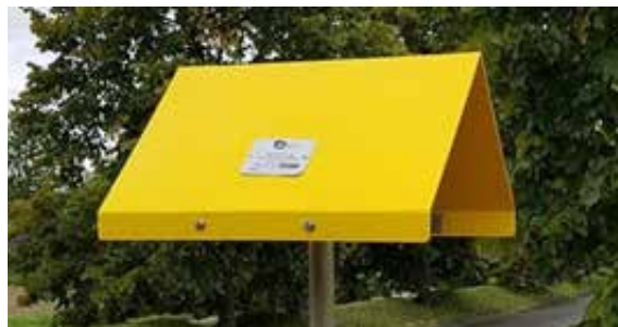
Ce poteau prévient de la présence de canalisations de gaz enterrées près des routes.
