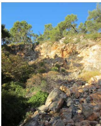
Sécurisation du vallon des Hirondelles / Avant
