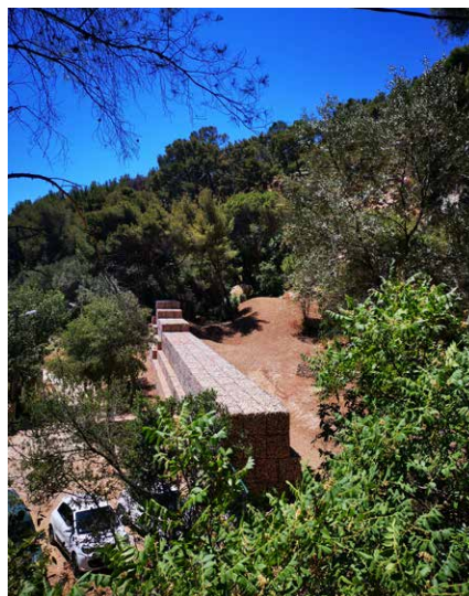
Sécurisation du vallon des Hirondelles / Après
