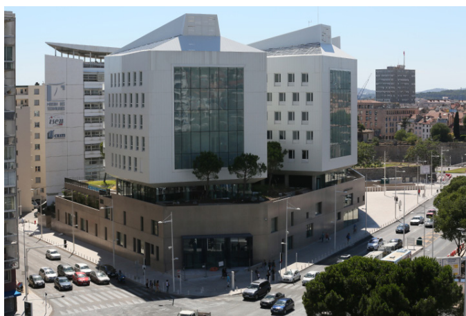
UFR Ingémédia - Toulon
