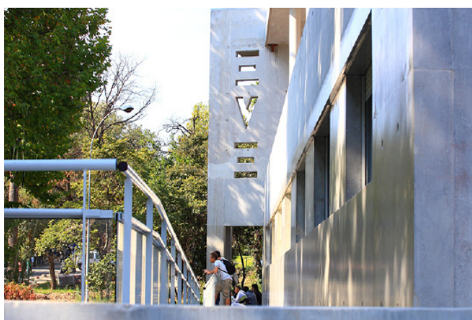
Bâtiment EVE - La Garde
